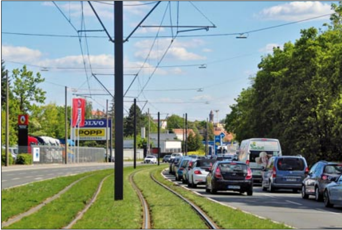
Vor der Einfahrt in das verdichtet bebaute Nürnberger Stadtgebiet beginnt die Rückstauzone, die der Straßenbahn dank des eigenen Gleiskörpers nichts anhaben kann.
