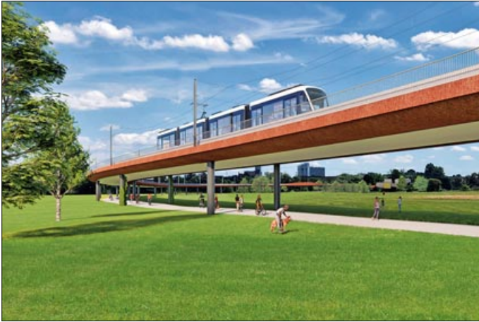
Die StUB muss von Erlangen in Richtung Herzogenaurach zunächst die breite Regnitzau mit dem gleichnamigen Fluss queren; der gesamte Bereich ist teils naturräumlich, teils für die Naherholung von großem Wert und erfordert eine entsprechend sorgfältige Gestaltung der Bahntrasse. Man hat sich für eine auf ganzer Länge aufgeständerte Führung der Gleise entschieden, unter dem Bauwerk wird ein Fuß- und Fahrradweg angelegt. Die grazil dimensionierten Stahlstützen weisen einen Durchmesser von lediglich 0,71 m auf...
