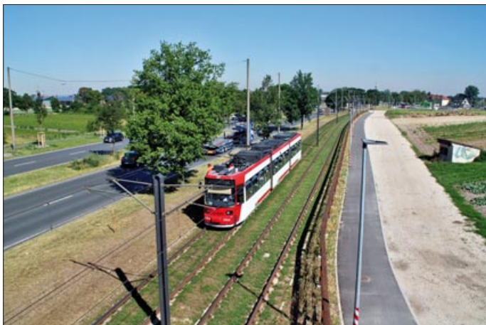
Die Nürnberger Teilstrecke der Stadt-Umland-Bahn kurz vor ihrer Endhaltestelle Am Wegfeld zeigt die im städteverbindenden Abschnitt überwiegend vorge-sehene Ausprägung mit der Lage des Bahnkörpers neben der B4.
