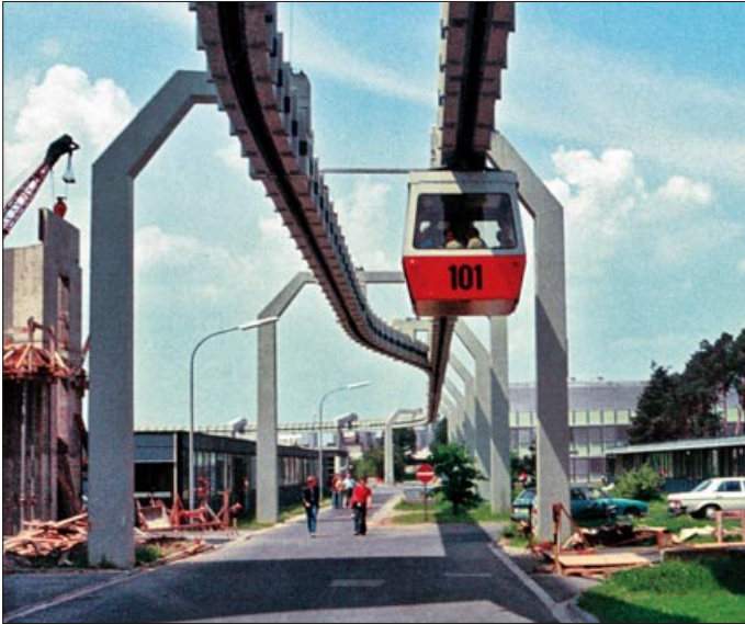
Die H-Bahn erzeugte keine Trennungseffekte, stellte sich insgesamt leichter dimensioniert dar und wäre wohl auch relativ preisgünstig zu haben gewesen, konnte sich aber dennoch nicht durchsetzen (Siemens-Forschungsgelände Erlangen). Aufnahme: Sammlung Freunde der Nürnberg-Fürther Straßenbahn
