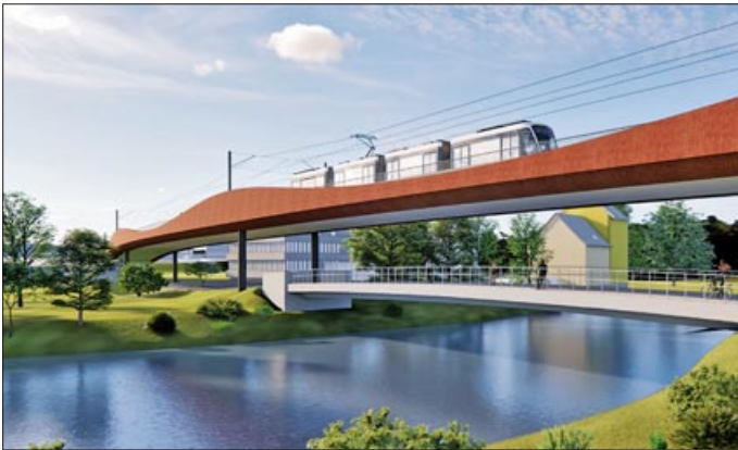
...davon ausgenommen sind nur wenige Stützen mit 1,0 m Durchmesser im Bereich der direkten Flussquerung. Abbildungen (2): Claus Hirche/ZV StUB
